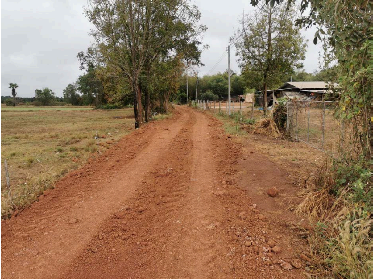
ภาพถ่ายการซ่อมแซมถนนลูกรังในพื้นที่ตำบลวังดาล
